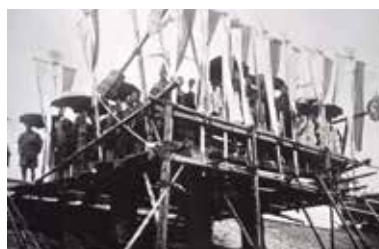
左：第二号石蔵 右：第二号竣工式
